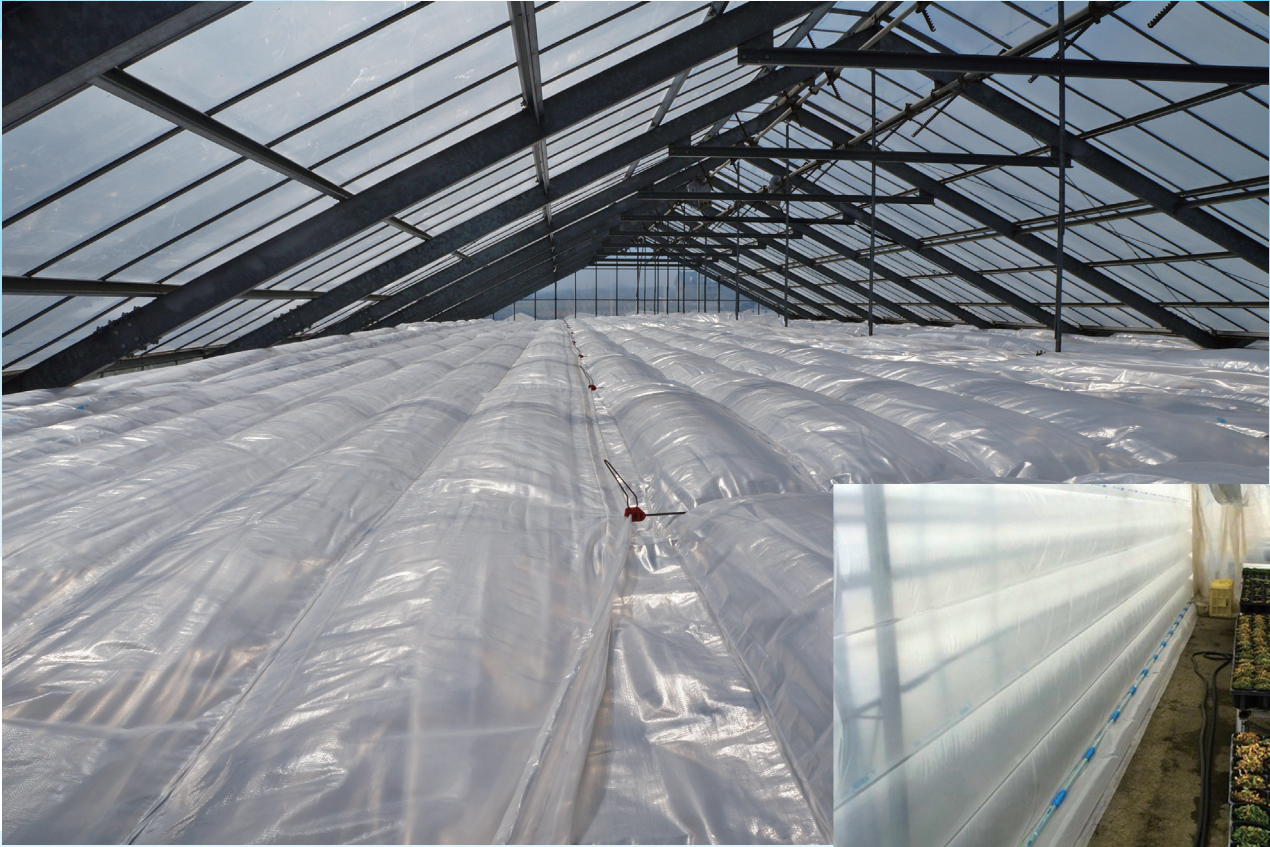
ハウス内張り屋根部の使用例
